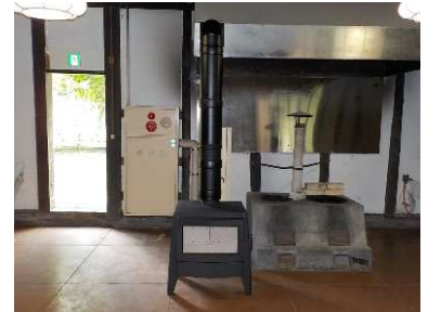
9月：薪ストーブ新設
