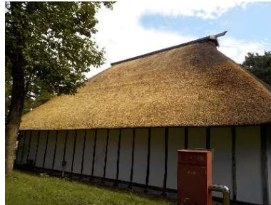
9月：西側屋根完成
