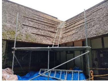
7月開始：東側屋根修繕
