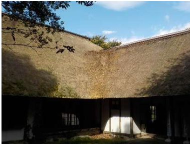
9月：東側屋根完成
