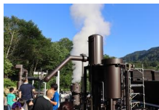
「滝ノ上地熱バイナリー発電所見学」
